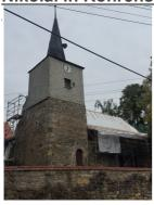
Im Juli 2019 begannen endlich die Sanierungsärbeiten an der Kirche St. Nikolai in Röhrensee. Ziel ist es im ersten Bauabschnitt, das Kirchendach neu einzudecken, die Mauern zu sichern und die Regenentwässerung herzustellen. Zuerst wurde das Dach abgedeckt und mit Planen eine provisorische Abdichtung für die Dauer der Bauarbeiten errichtet. Schnell zeigte sich, wie bereits vermutet, dass eine Vielzahl an Holzbalken ausgetauscht und das Mauerwerk stabilisiert werden muss.
